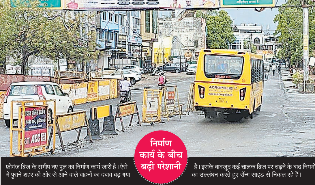
फ्रीगंज ब्रिज के समीप नए पुल का निर्माण कार्य जारी है। ऐसे में पुराने शहर की ओर से आने वाले वाहनों का दबाव बढ़ गया है। इसके बावजूद कई चालक ब्रिज पर चढ़ने के बाद नियमों का उल्लंघन करते हुए रॉन्ग साइड से निकल रहे हैं।
